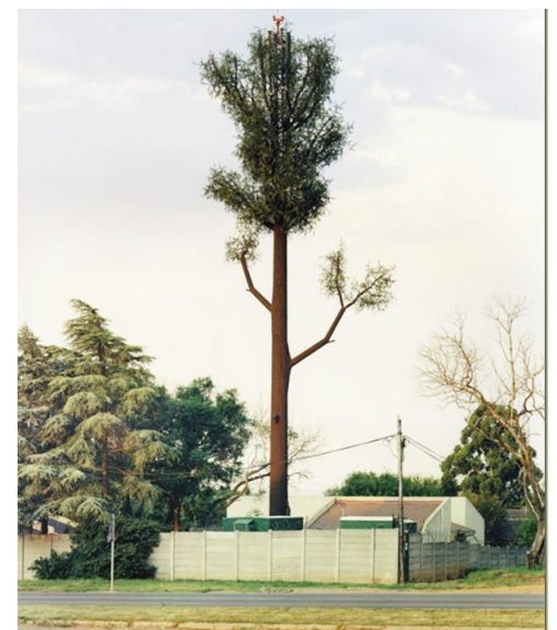
Antenne relais de téléphone mobile subtilement déguisée
