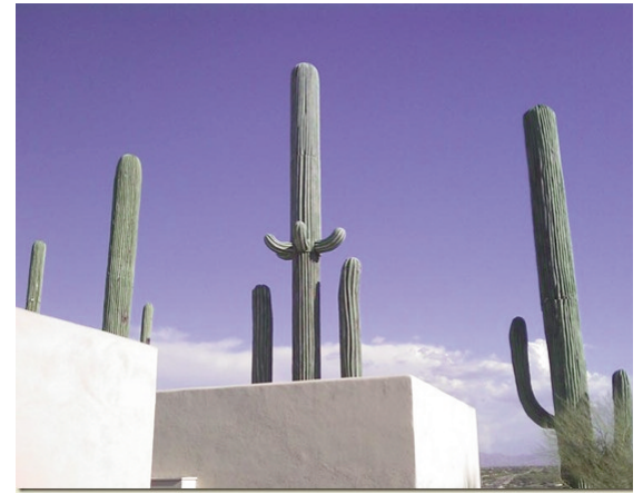
Antenne relais de téléphone mobile «totale-ment» déguisée
